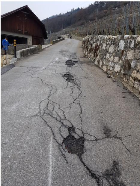
Belagsschäden bei der Zufahrt Oberdorf Tüscherz vor den Sanierungsarbeiten. (Bild: zvg)
