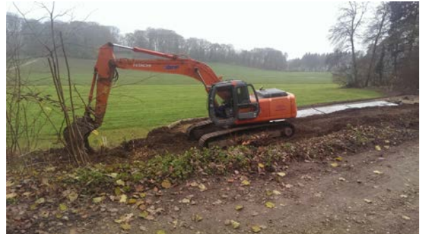
Dank Baggereinsatz geht es vorwärts mit der Kugelfangsanierung des Schiessstands Bränneli. Bild: zvg
