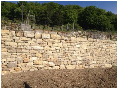
Neue Trockenmauer Bielweg.
