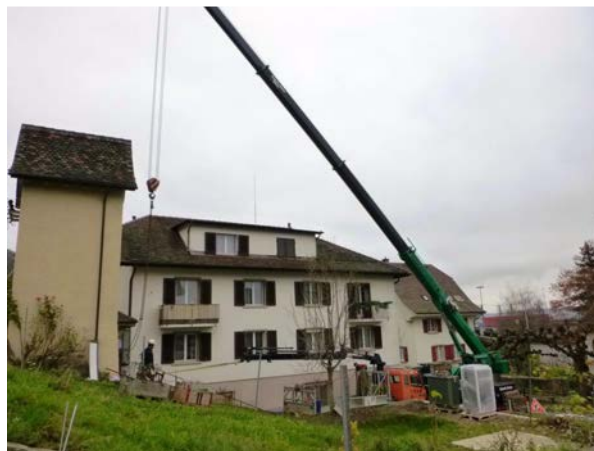
Anfangs Dezember 2014: Die Arbeiten an der Trafostation Moos sind in vollem Gang. Bild: Diego Zulian
