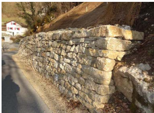
Neue Trockenmauer Chapfstrasse.
