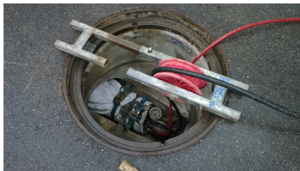
Vor der Aushärtung mit den UV-Lichtquellen wird der Schlauch mit Luft aufgedrückt und mit der Kanalfern-sehkamera vorkontrolliert.
