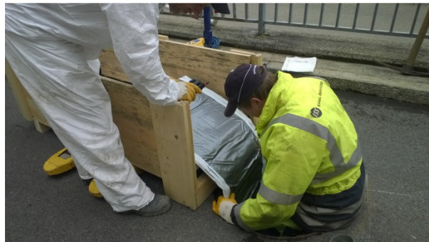
Nach Abschluss und Kontrolle der Vorbereitungsarbeiten wird als erstes ein vorkonfektionierter Glasfaser-schlauch in den zu sanierenden Kanalabschnitt einge-zogen.
