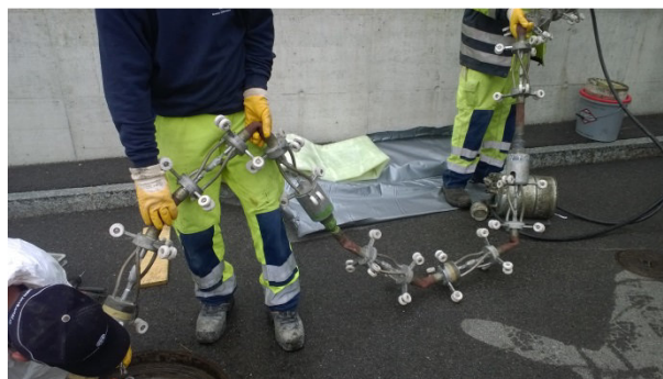
In den fertig eingezogenen Schlauch wird anschlies-send eine UV-Lichtkette eingebaut, mit welcher der Schlauch zum Schluss automatisch gesteuert ausge-härtet wird.
