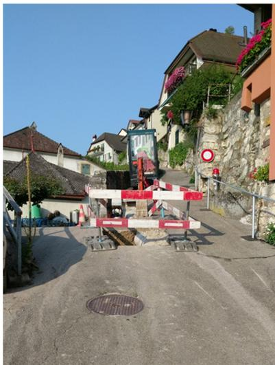
Baugrube im Dorfweg Tüscherz, notwendig für den Einbau der Kanalsanierungs-Roboter in die Leitung
