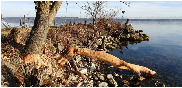
Schaden von Wellenschlag und Biber im Twannbach-delta. Bild: hs
