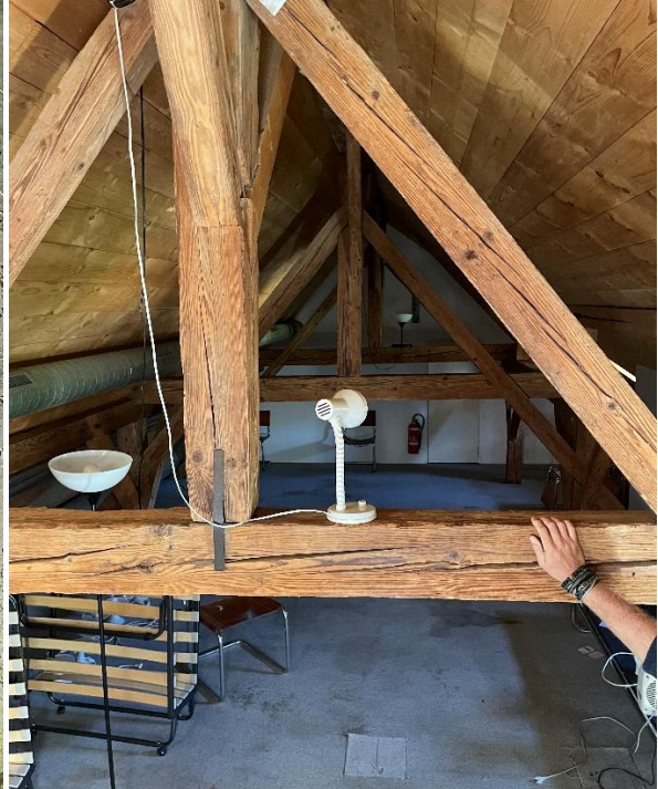
Abbildung 7 Ausgebauter Teil des Estrichs, Bereich Nord-west
