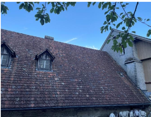
Abbildung 10 Sicht vom Innenhof auf Flügel Ost mit Anbau
