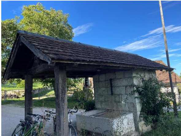
Abbildung 12 Waschhaus – das Nebengebäude beherbergt auch eine Kolonie von Mückenfledermäusen unter dem Metall im Firstbereich
