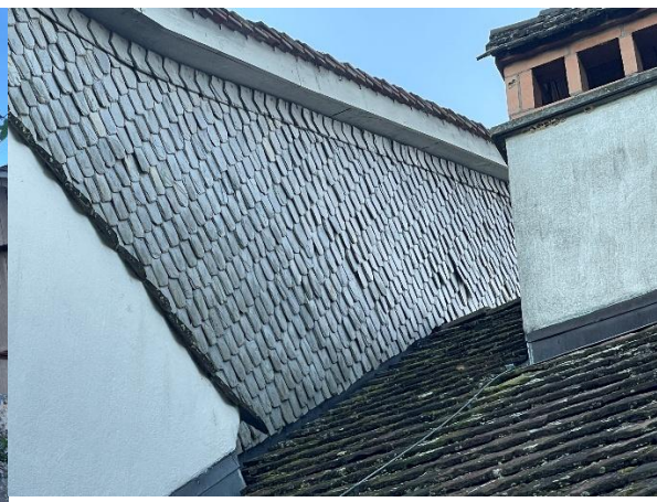
Abbildung 11 Fassade Flügel Ost mit Schieferplatten
