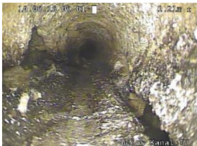
Vor/nach einer Leitungssanierung
