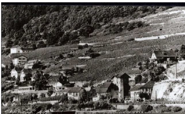
Alfermée vor dem Bau der N5, um 1960.
